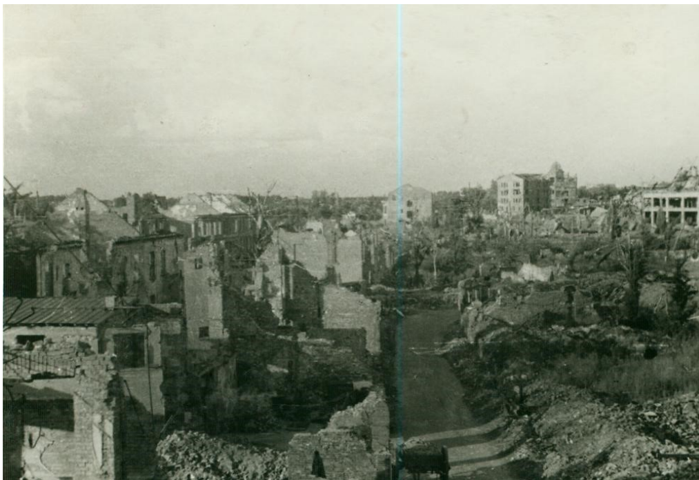
Abb. 1.: Gesamtüberblick über die zerstörte Stadt vom Krankenhaus aus, 1944.
