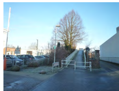
Fußgängerbrücke Nierenberger Straße
